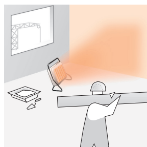
Asciugatura di parete in costruzione.
