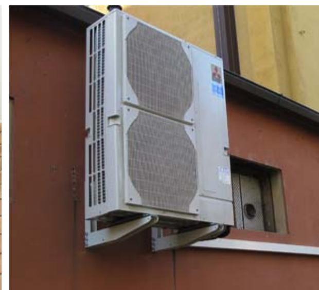
Salvo casi particolari, carichi di trazione per singolo ancorante  $\leq 0,50$  kN (50 Kg)
