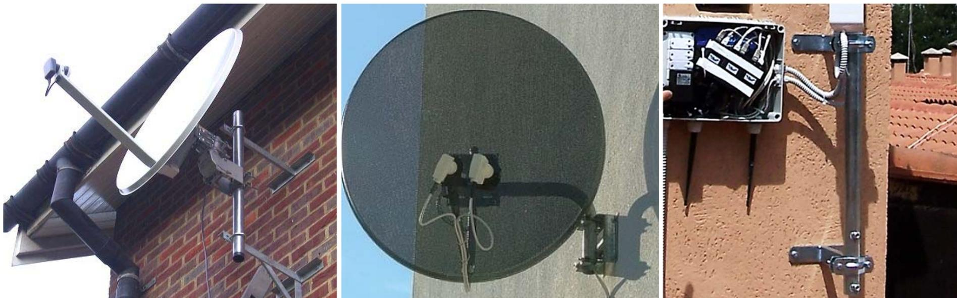
Salvo casi particolari, carichi di trazione per singolo ancorante  $\leq 0,50$  kN (50 Kg)
